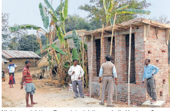
Nicht nur richtiges Essen ist wichtig, auch die Hygiene. So werden weitere Waschhäuser mit Toiletten errichtet.
